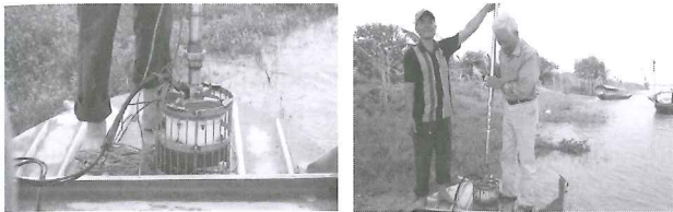
Hình 4.2: Một số hình ảnh chuẩn bị đo xói cục bộ trụ cầu
